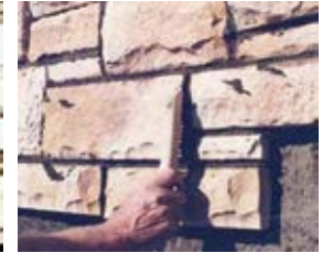
5. Bağlantı yerindeki veya taş yüzeyindeki fazladan harcın parçalarını temizlemek için tel bir fırça kullanın. Harcın yüzeyde kurumasına izin vermeyin.
