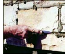
4. Tel fırçanın arkasını, çita veya benzer bir şeyi kullanarak, sertleşmeden önce harcı ayarlamaya başlamak üzere harcı bağlantı yerlerine bastırın. Bu işlem erken yapıldığında harç taş yüzeyinden sıvanabilir veya harca pürüzsüz bir görünüş verebilir.
